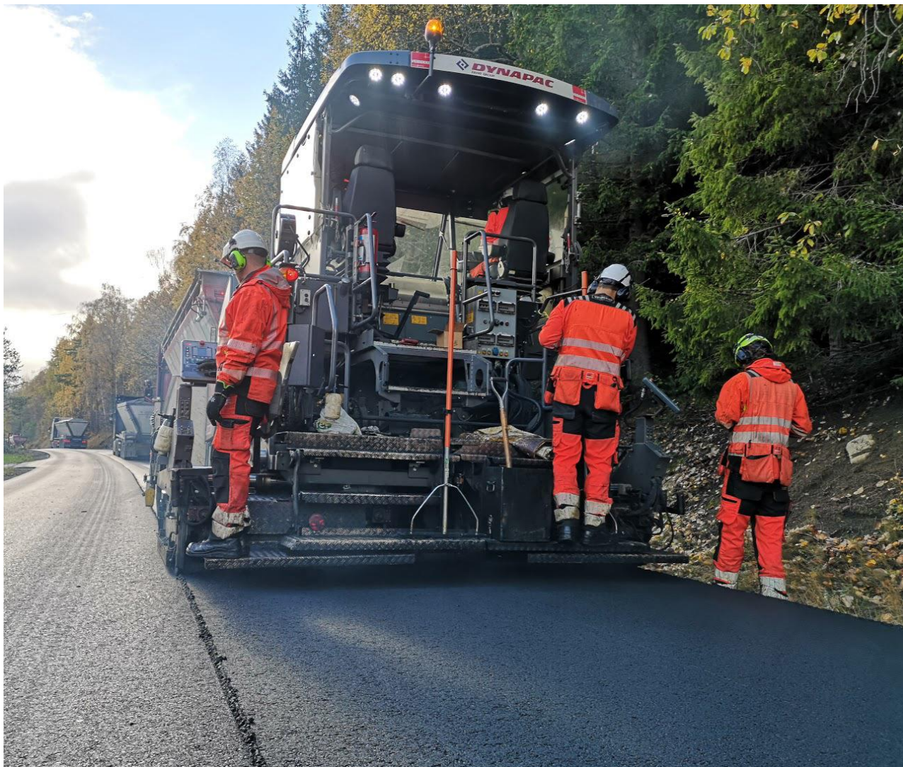
Figur 8 Pilotering av “Miljøasfalt” i oktober 2020 (Foto: Veidekke).
