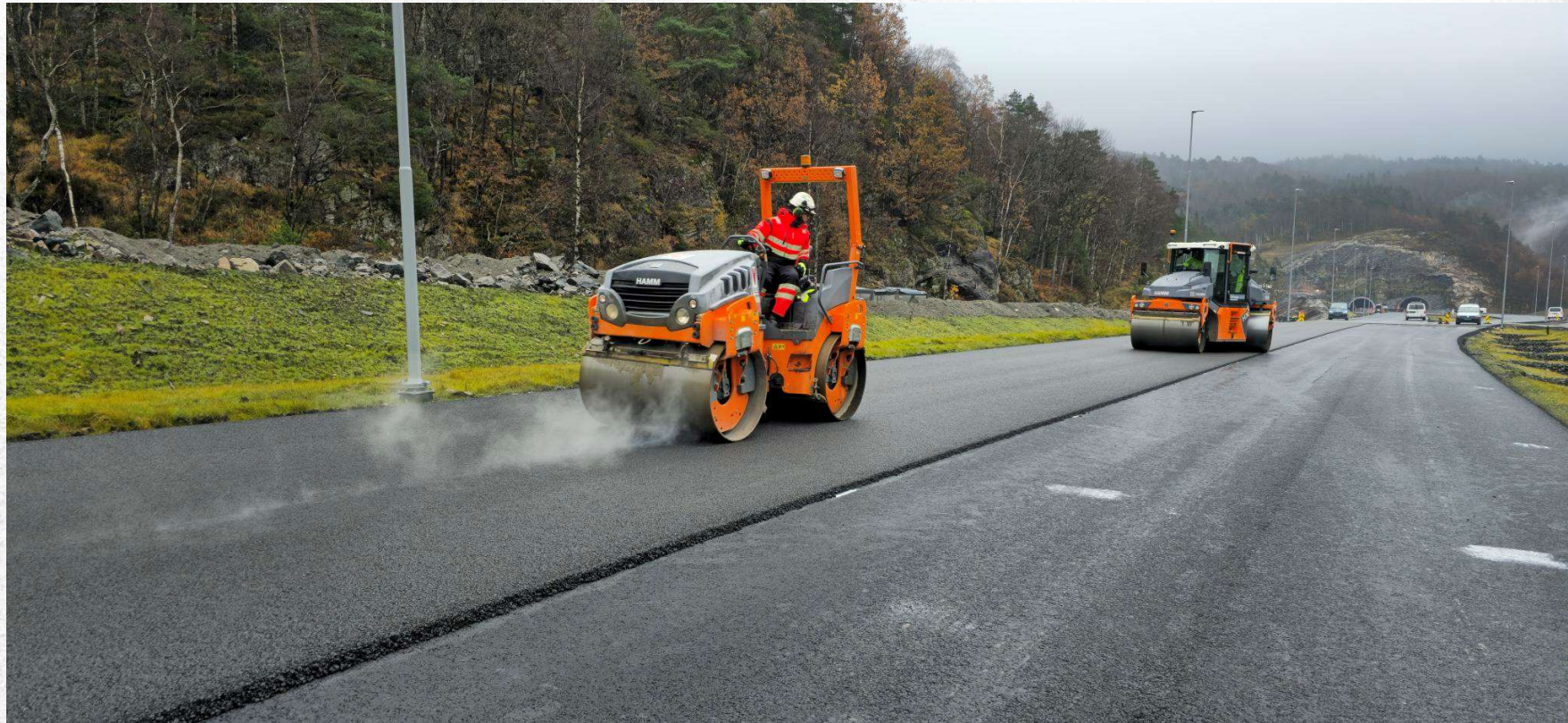
Asfaltering av Ab 16 sirkulært slitelag
