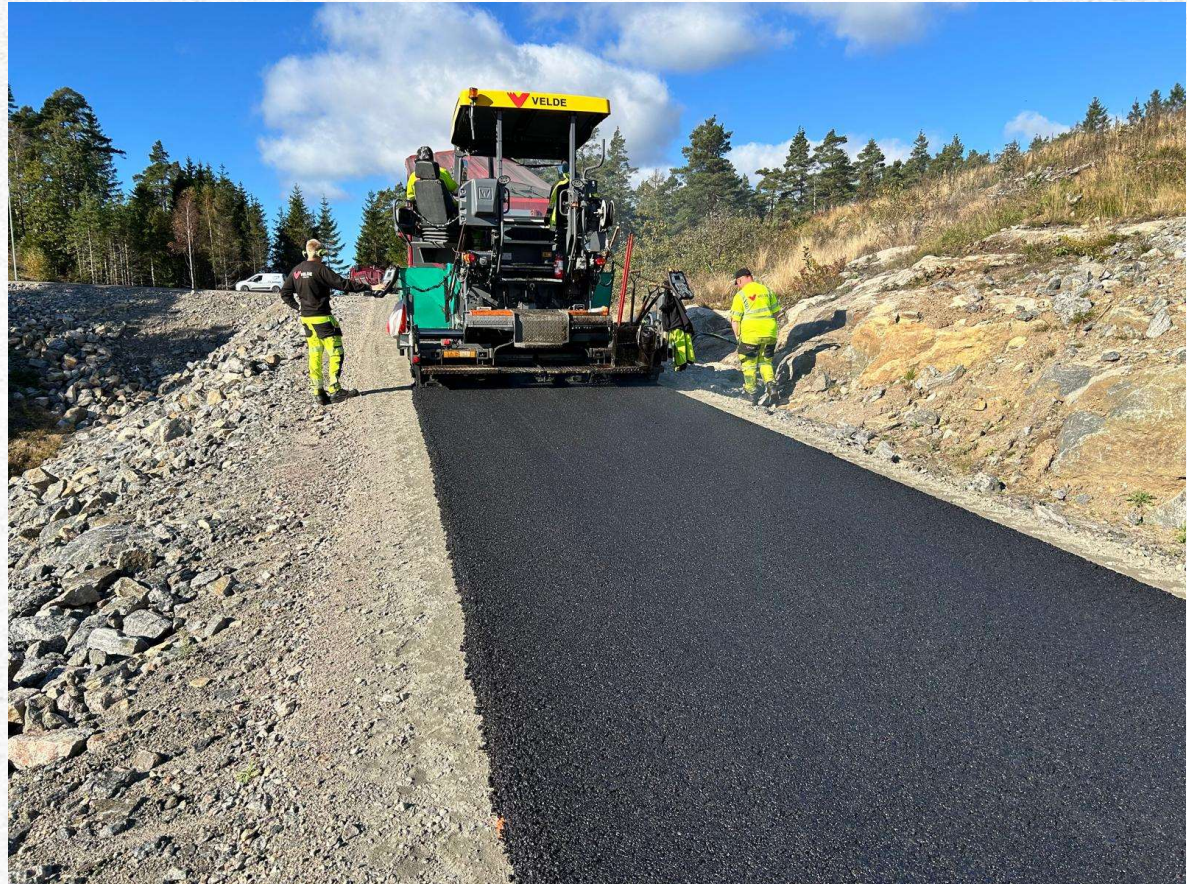
Asfaltering av prøvedekke Agb 16 og Ab 16
